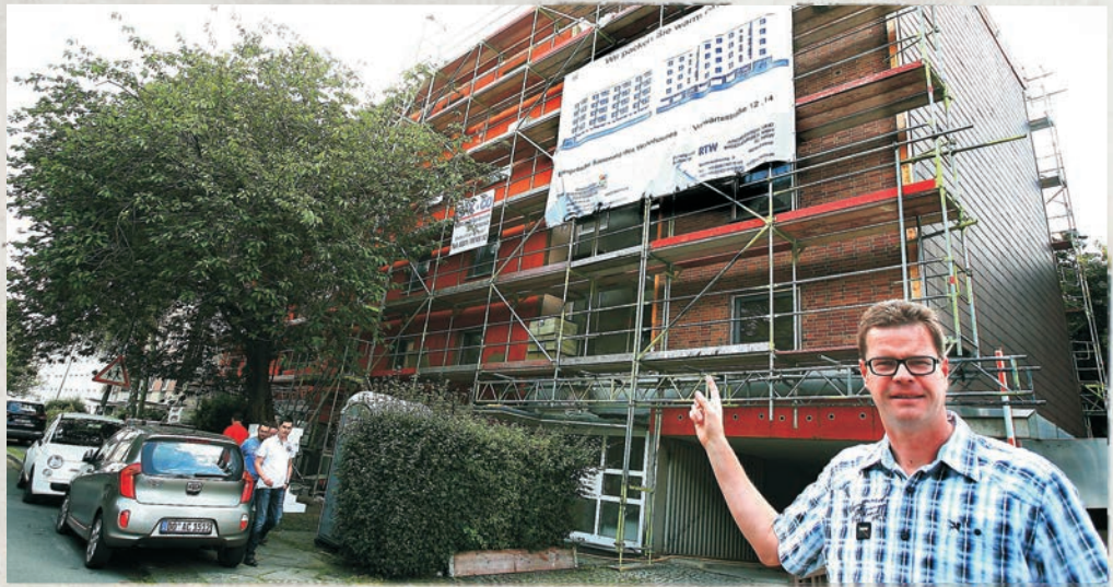
Markus Beer vor Häusern der Genossenschaft an der Vorwärtstraße, die gerade energetisch saniert werden.
